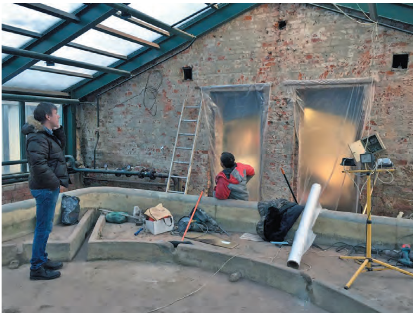
Строительство Викторной оранжереи.
